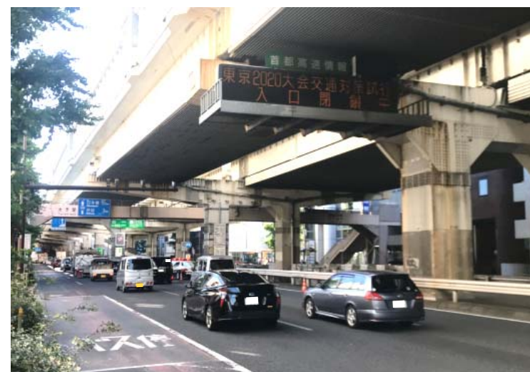
入口閉鎖(国道246号 三軒茶屋入口周辺)
