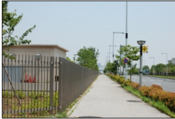
図 5-10-14 (2) 15～16 東京ビッグサイト・ホールA、B、東京ビッグサイト（IBC/MPC） における評価地点の現況
