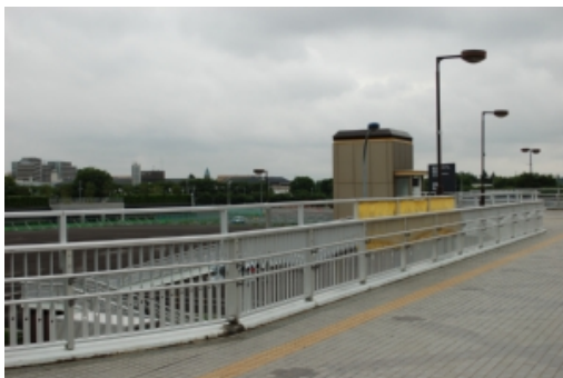
29 武蔵野の森総合スポーツ施設 撮影地点②
