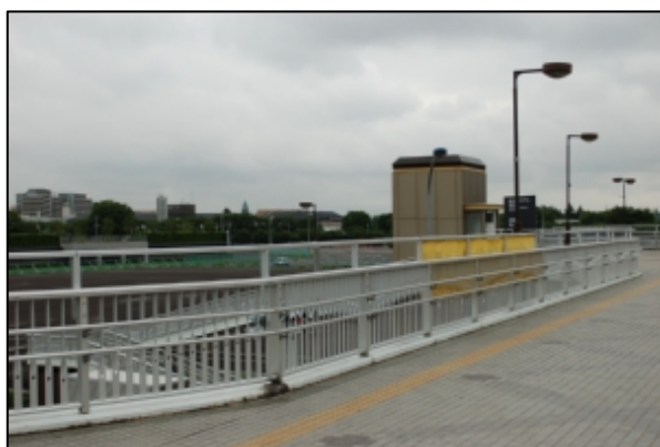
図 5-10-21 (2) 29 武蔵野の森総合スポーツ施設における評価地点の現況
