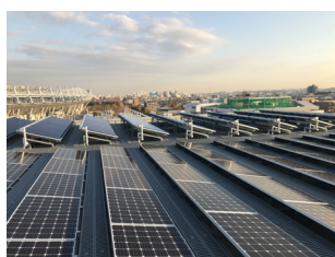
写真提供：東京都 太陽熱利用設備・太陽光パネル（武蔵野の森総合スポーツプラザ）
