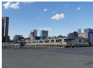
築地輸送デポの建設状況 (2020年2月)
