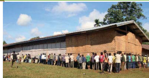
飯舘村の支援で建設された学校
