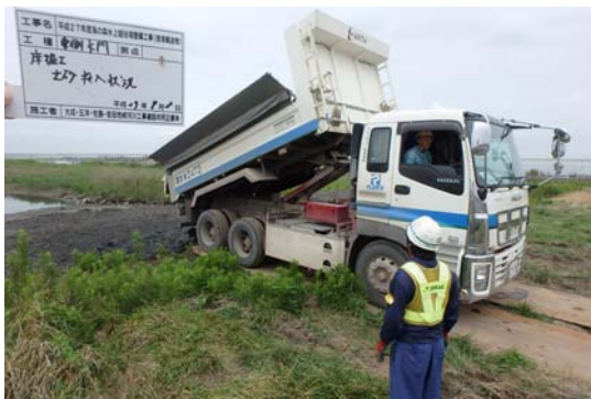
写真 8.7-3 発生土の中央防波堤区内利用 (再掲)
