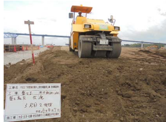
写真 8.13-2 発生土現場内利用
