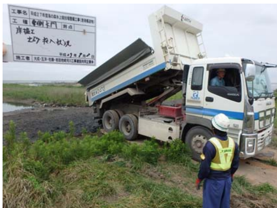
写真 8.10-3 発生土の中央防波堤区内利用
