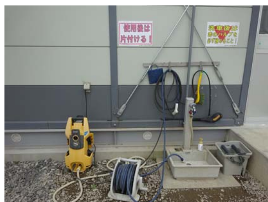
写真 8.1-4 タイヤ洗浄装置
