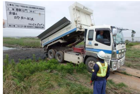
写真 8.1-2 発生土の中央防波堤区内利用
