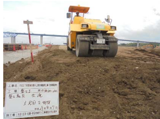
写真 8.10-2 発生土現場内利用
