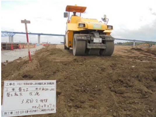
写真 8.1-1 発生土現場内利用
