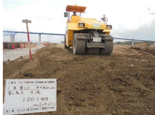
写真 8.7-2 発生土現場内利用
