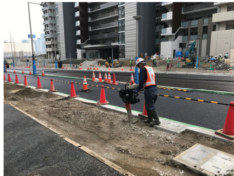
写真 6.8.6-6 再生碎石の使用
