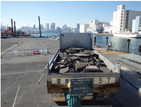
写真 6.8.6-3 アスファルト塊分別収集
