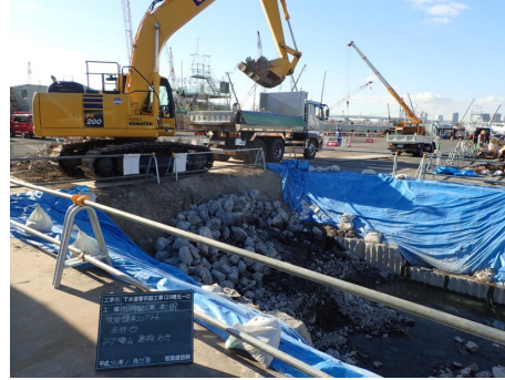
写真 6.8.6-2 コンクリート塊分別収集
