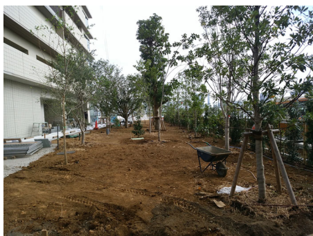
写真 6.8.3-1 植栽基盤の施工の状況
