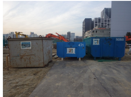
写真 6.8.6-2 コンクリート塊分別収集
