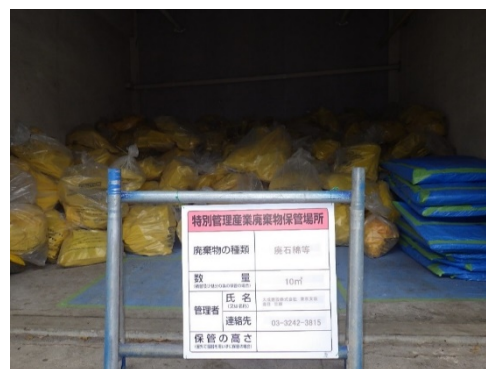
写真 8.8-4 アスベスト保管状況
