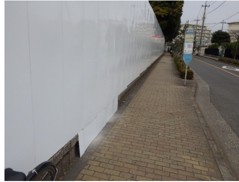
写真 8.1-10 北エリア地下道スロープ施工範囲における鋼製仮囲い (3m)
