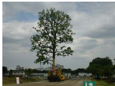
写真 8.3-6 クヌギの移植状況
