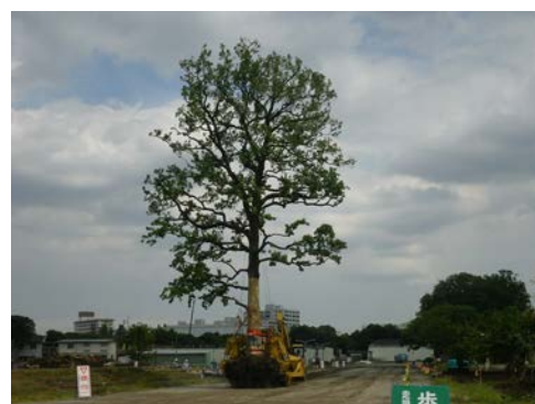
写真 8.8-6 クヌギの移植状況
