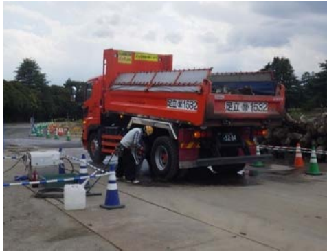
写真 8.1-1 タイヤ洗浄設備
