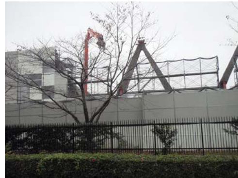
写真 8.1-12 パネル+防音シート
