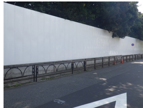
写真 8.5-6 北エリアにおける鋼製仮囲い (3m)
