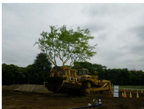
写真 8.4-5 モミジの移植状況
