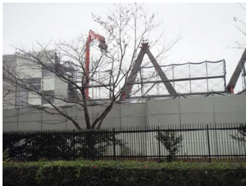
写真 8.5-9 パネル＋防音シート
