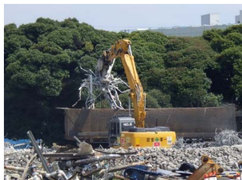
写真 8.8-2 分別解体工事
