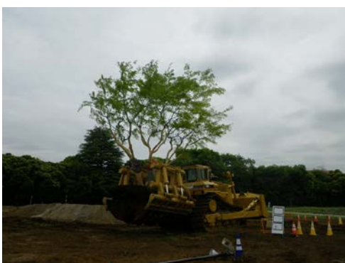
写真 8.7-5 モミジの移植状況
