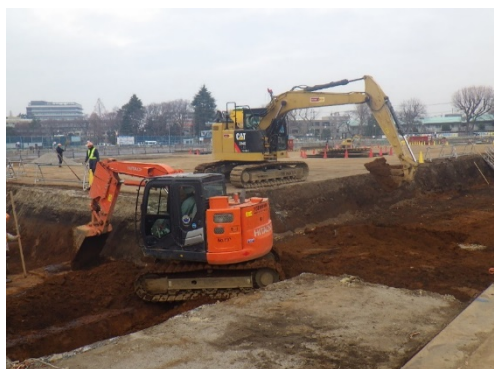
写真 8.8-1 建設発生土埋戻し
