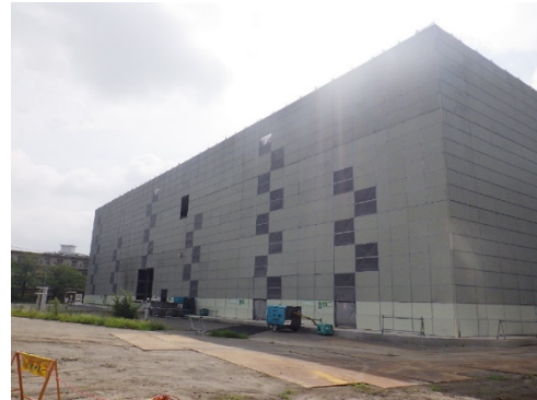
写真 8.1-14 工事範囲周辺の防じんカバー
