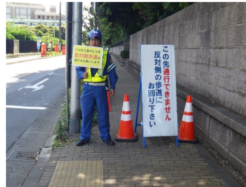
写真 8.11-2 歩道占用工事での歩行者安全対策
