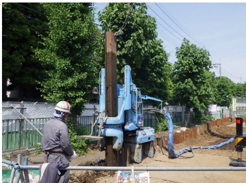
写真 8.5-13 サイレントパイラー工法
