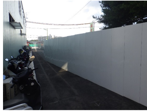
写真 8.5-8 南エリア地下道スロープ施工範囲における鋼製仮囲い（2m）
