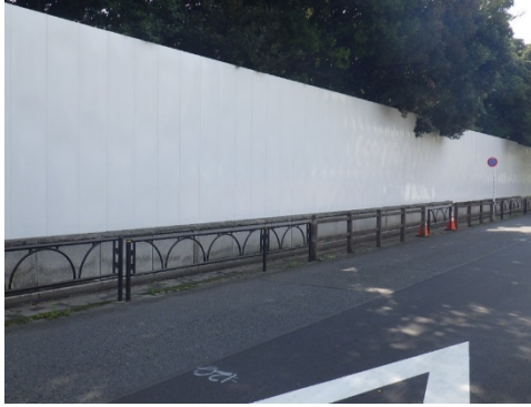
写真 8.1-9 北エリアにおける鋼製仮囲い (3m)
