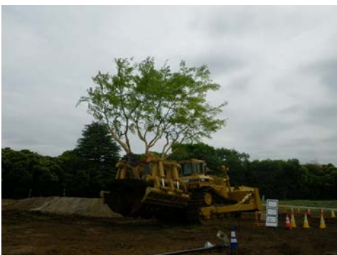
写真 8.3-5 モミジの移植状況
