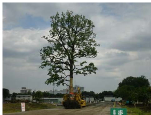
写真 8.6-6 クヌギの移植状況
