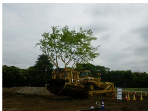
写真 8.8-5 モミジの移植状況
