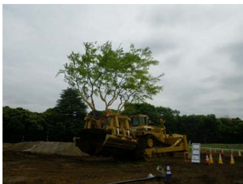
写真 8.6-5 モミジの移植状況
