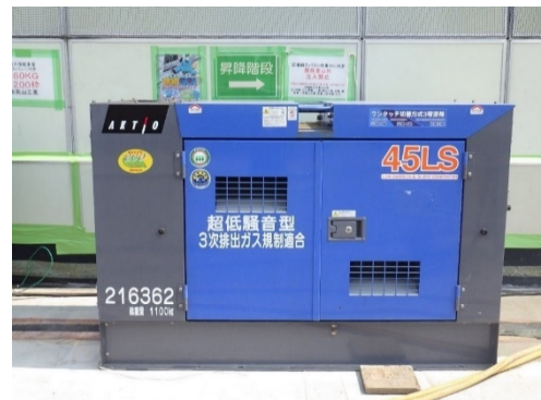
写真 8.1-16 第3次対策型建設機械
