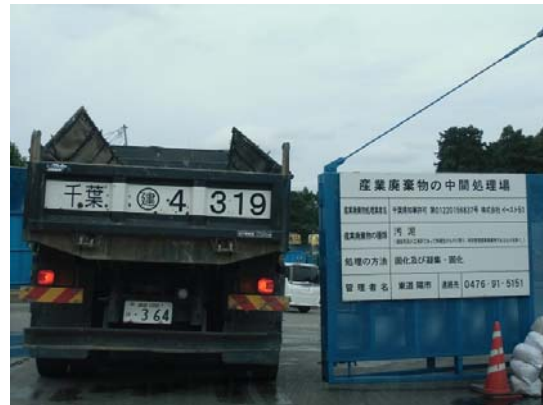
写真 8.4-2 建設汚泥の再資源化施設への搬入
