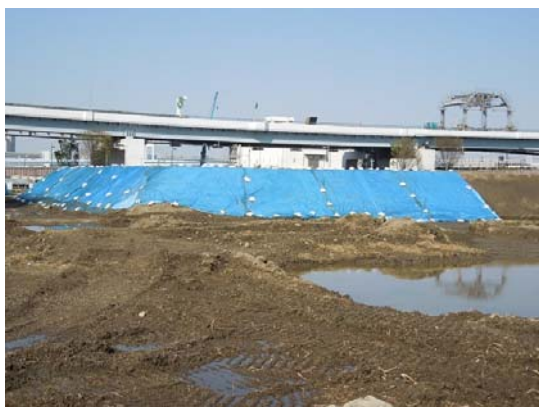
写真 8.1-11 粉じん飛散防止シート
