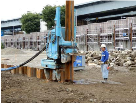
写真 8.2-9 サイレントパイラー工法
