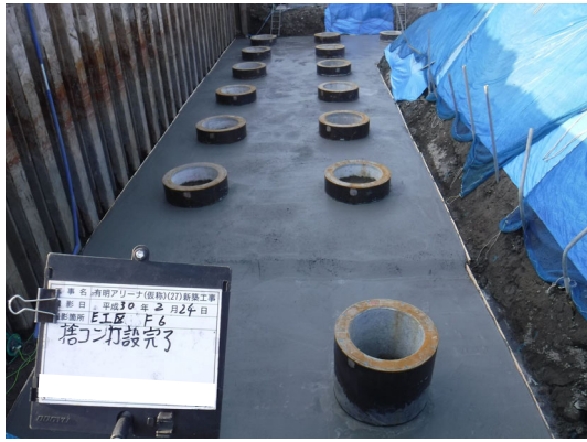
写真 8.3-1 捨てコンクリート打設状況
