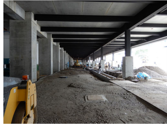
写真 8.3-2 再生砕石の使用状況
