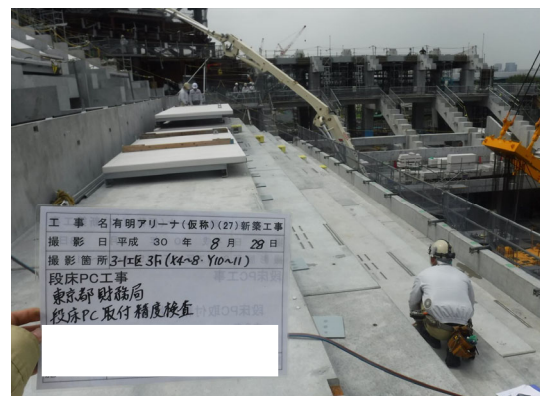
写真 8.2-8 PCa 化の状況（段床工事）
