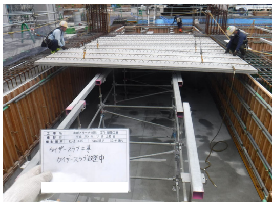
写真 8.2-7 PCa 化の状況（スラブ工事）
