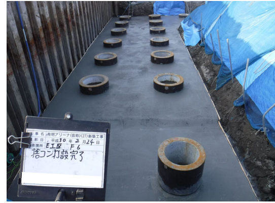
写真 8.2-10 捨てコンクリート打設状況
