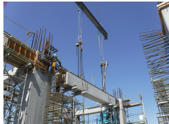
写真 8.2-6 PCa 化の状況（梁工事）
