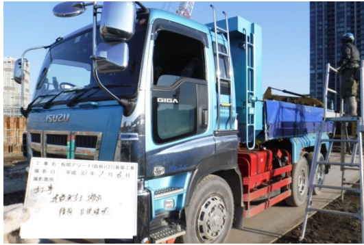
写真 8.2-1 建設発生土の再利用施設への搬入
