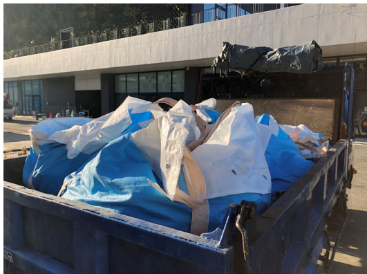
写真 8.2-5 再資源化施設搬入
