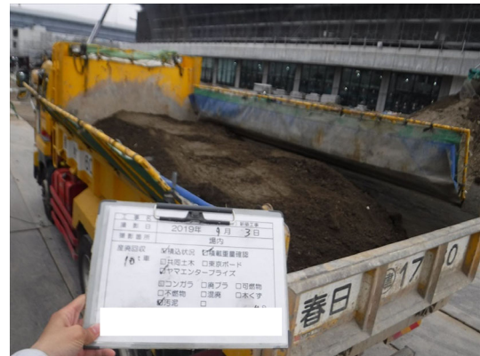
写真 8.2-2 建設泥土の再資源化施設への搬入
