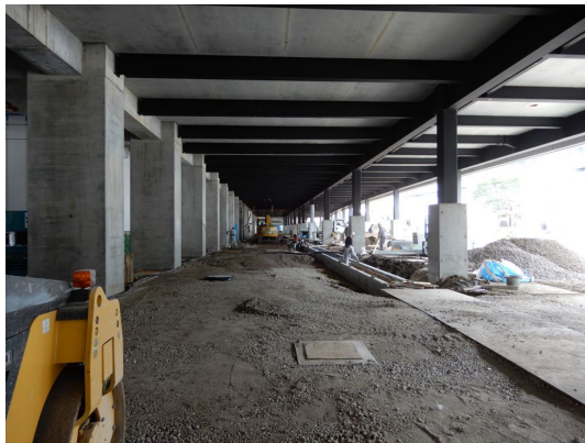
写真 8.2-11 再生砕石の使用状況
