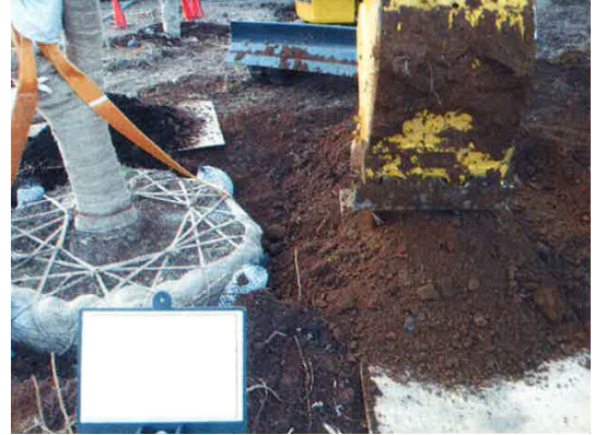
写真 8.2-2 良質土による埋戻し
