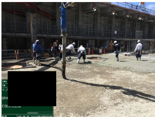
写真 8.10-1 再生骨材コンクリート打設
