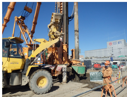
写真 8.5-12 静的締固め砂杭工法
