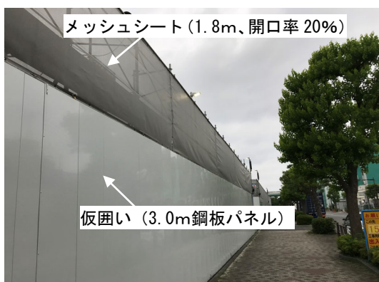
写真 8.1-13 仮囲い及びメッシュシート
