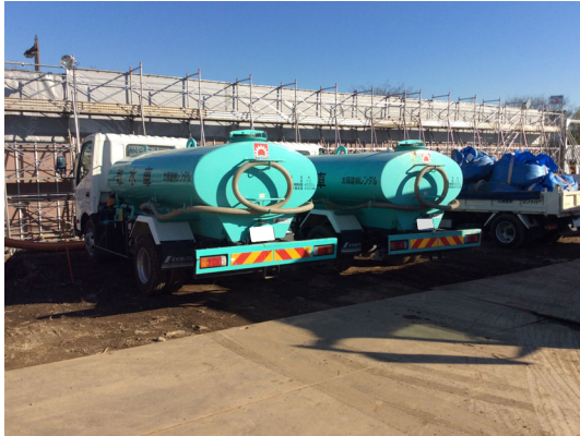
写真 8.8-3 散水車による散水
