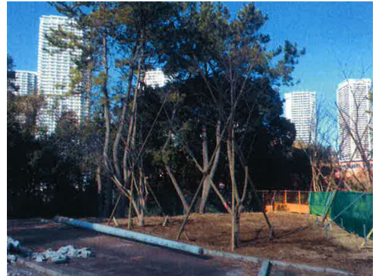
写真 8.2-4 支柱設置状況
