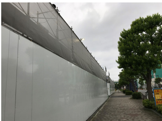
写真 8.5-9 仮囲い及びメッシュシート
