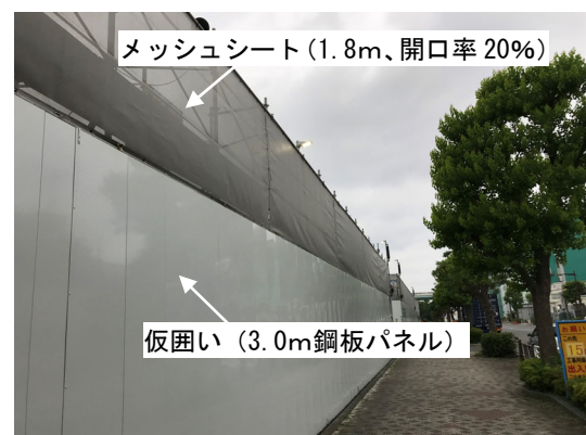
写真 8.8-2 仮囲い及びメッシュシート
