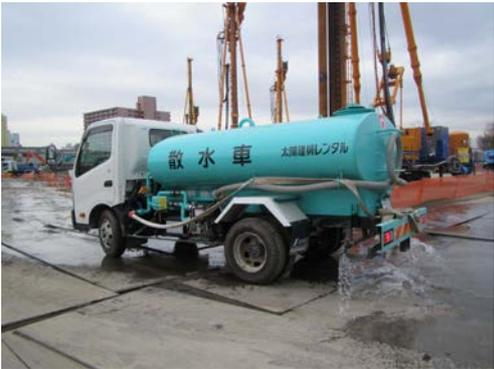
写真 8.1-11 散水車による散水
