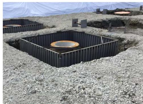
写真 8.4-4 鋼製型枠の使用
