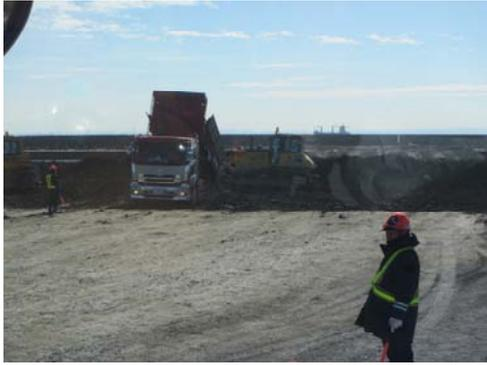
写真 8.4-1 建設発生土の再利用施設への搬入
