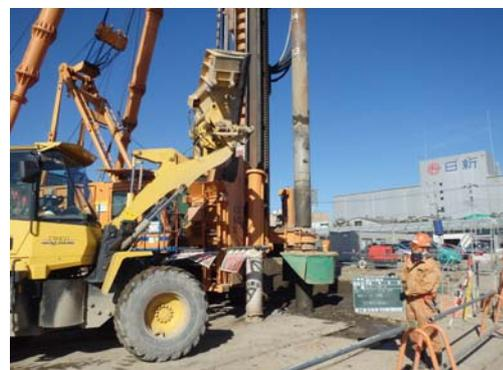
写真 8.2-8 静的締りめ砂杭工法
