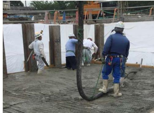
写真 8.4-6 再生骨材コンクリート打設
