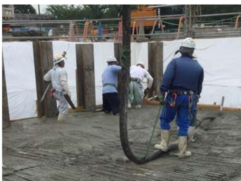
写真 8.5-1 再生骨材コンクリート打設
