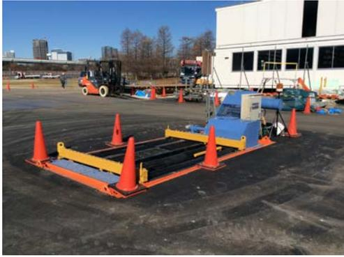
写真 8.1-1 タイヤ洗浄設備
