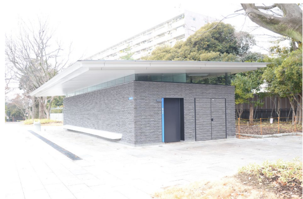
正門近くに設置されたトイレ
