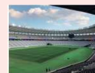
LED照明・高密度Wi-Fi (東京スタジアム)
