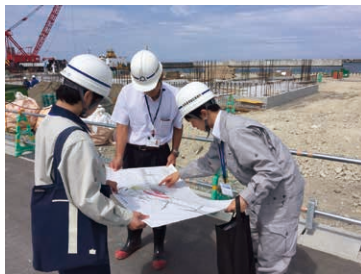
港の施工状況確認(被災地派遣職員)
