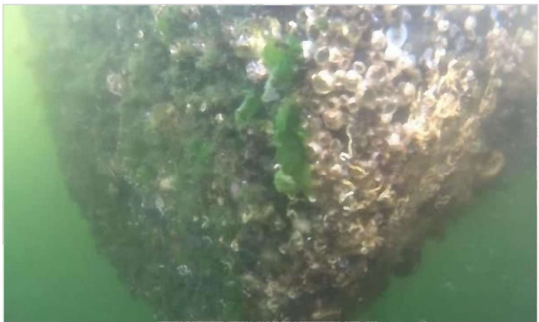
写真④ 水中端部
