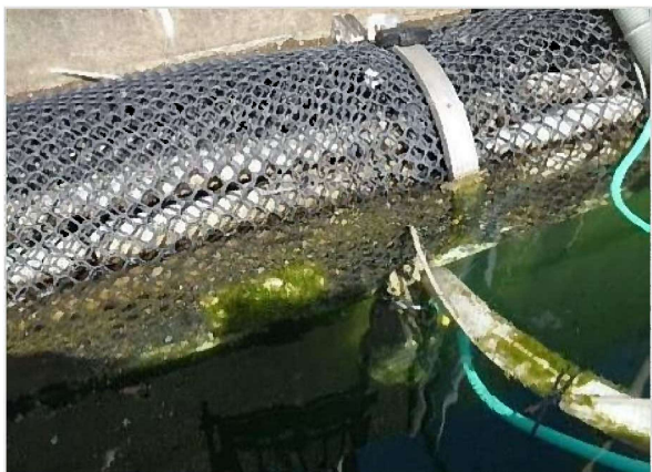
写真② 中央部
