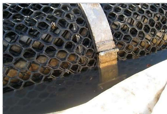
写真③ シート内部確認
