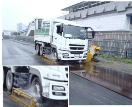
写真 8.2.1-2 タイヤ洗浄装置
