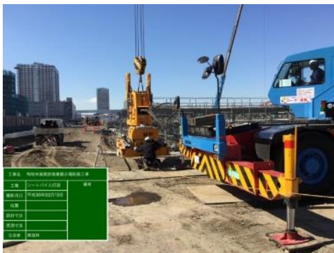
写真 8.2.2-11 サイレントパイラー工法の採用
