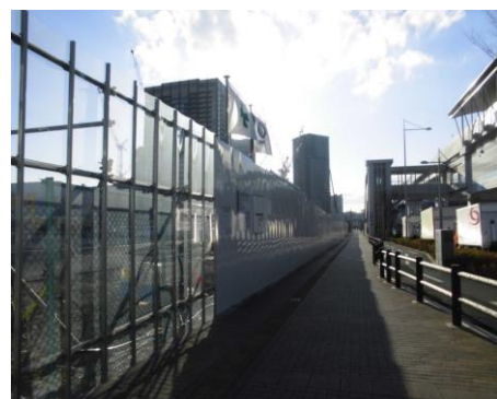
写真 8.2.2-6 仮囲い設置状況
