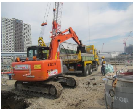
写真 8.2.4-1 発生土再利用施設搬出時
