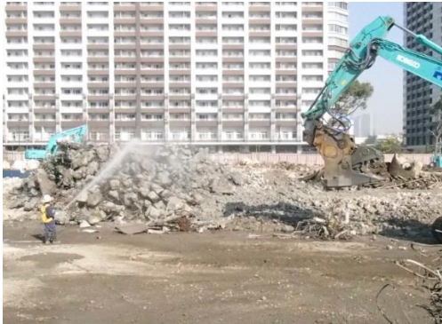
写真 8.6.1-11 解体時の散水
