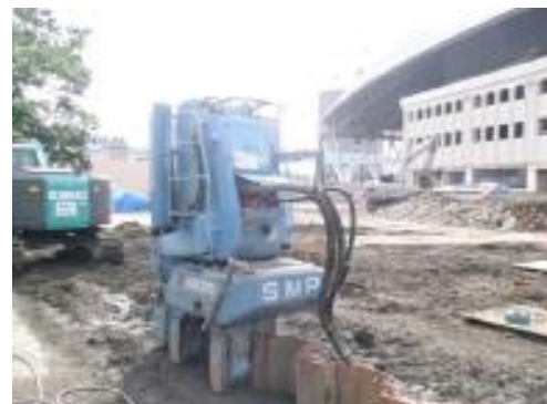
写真 8.6.2-8 サイレントパイラー工法
