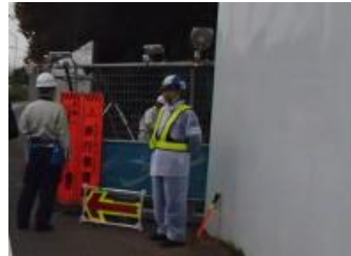
写真 8.6.4-4 歩道占用工事での 歩行者安全対策
