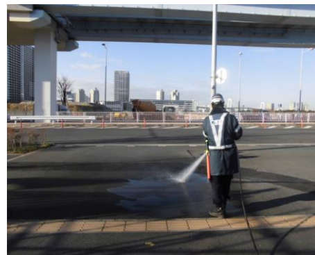
写真 8.2.1-8 路面清掃の状況
