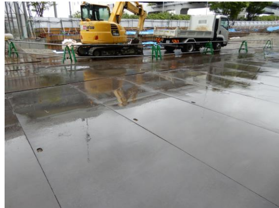
写真 8.5.1-2 鉄板敷設状況
