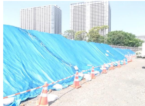
写真 8.6.1-12 飛散防止シート
