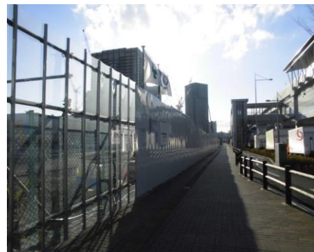
写真 8.2.1-10 仮囲いの状況
