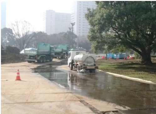
写真 8.6.1-11 解体時の散水
