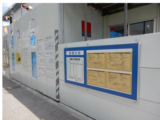
写真 8.5.2-7 近隣窓口問い合わせ先掲示板
