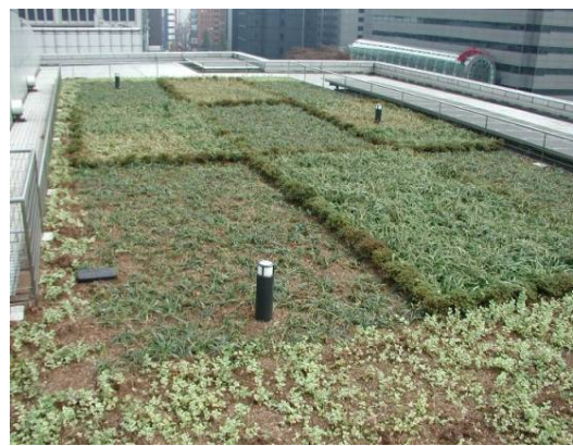
屋上緑化の例
